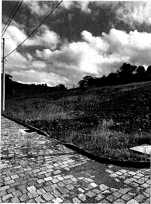
Esquinas com rebaixamento de meio-fio adequado.
