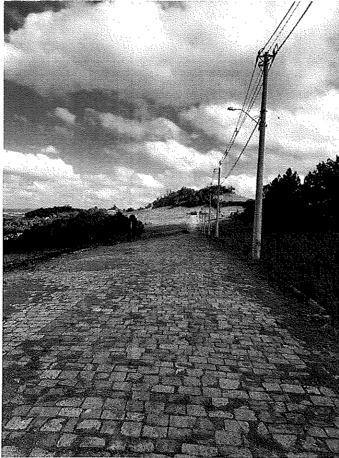
Vista da Rua Principal (Rua Pedro Luiz Anzolin) sentido norte-sul
